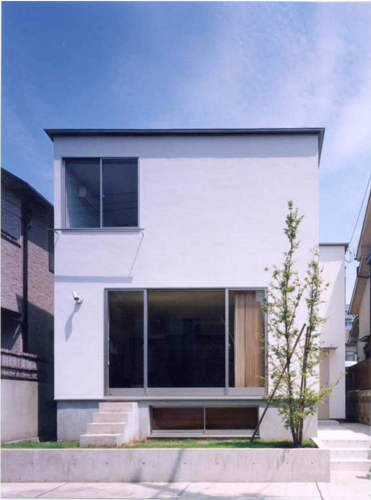
■道路側（南側）外観。下の開口部は半地階の和室の窓。
