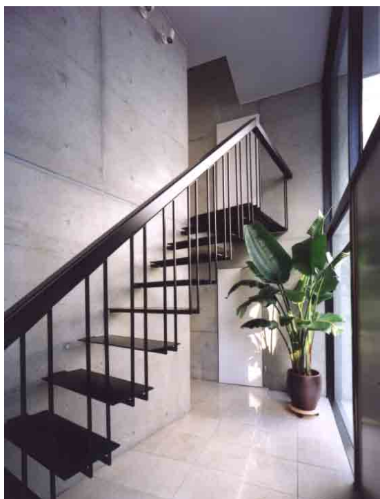
■ エントランス手摺を構造体とした吊構造の階段
