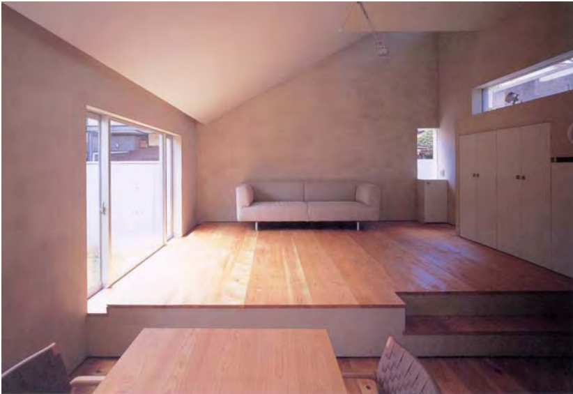
■ 食事室より居間方向を見る。床は25mm厚の無垢サワラ材。壁、天井は特注珪藻土。
