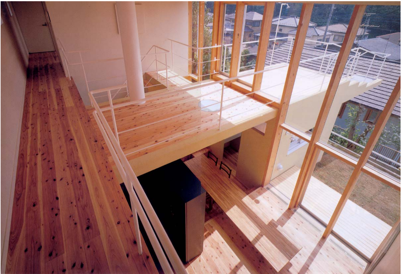
■ 2階廊下より吹抜けを見おろす。中央の床にある丸い乳白強化ガラスの開口が下階に柔らかな光を落とす。白い筒はOMソーラーのダクト。
