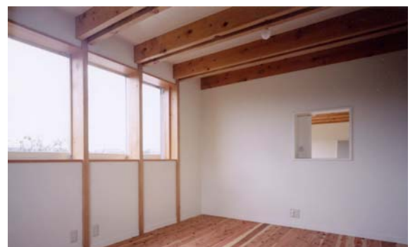
■ 将来用の子供室。個室にも柱、梁の構造が露出する。右側の小窓からは吹き抜けが見おろせる。
