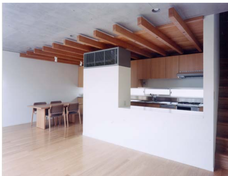
■ 2階居間より食事室、キッチン方向を見る。3階木造部の床をささえる木の梁が天井に見える。キッチンカウンターの上には端から端までの連続窓。
