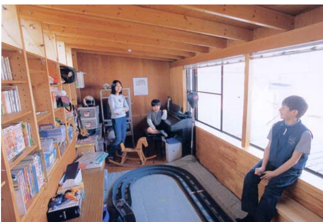
■ 3階の子供達のアトリエ。本棚は柱の間を利用しています。
