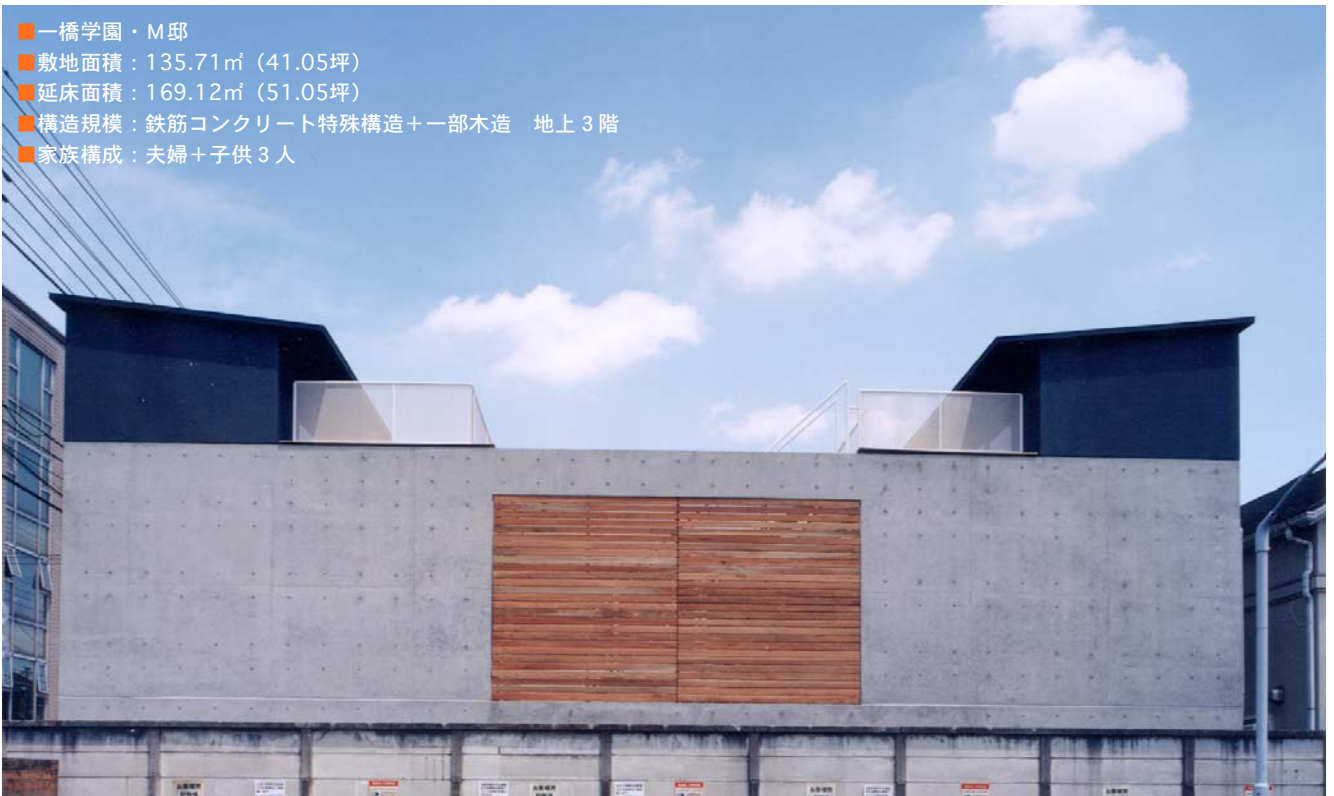
■西側外観。3階の黒い部分が木構造。
